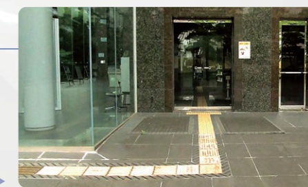
▶ 点字ブロック
